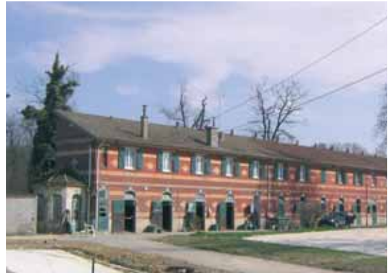
Ecurie dans le quartier du Bois Saint-Denis à Chantilly.
