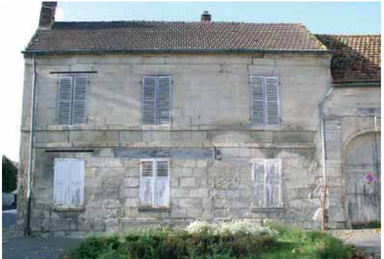
Maison typique en pierre calcaire taillée à Neuilly-sous-Clermont (Vallée de la Brèche).
