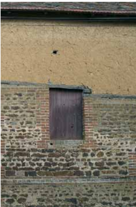
Torchis, bois, brique, grès ferrugineux (Armentières).
