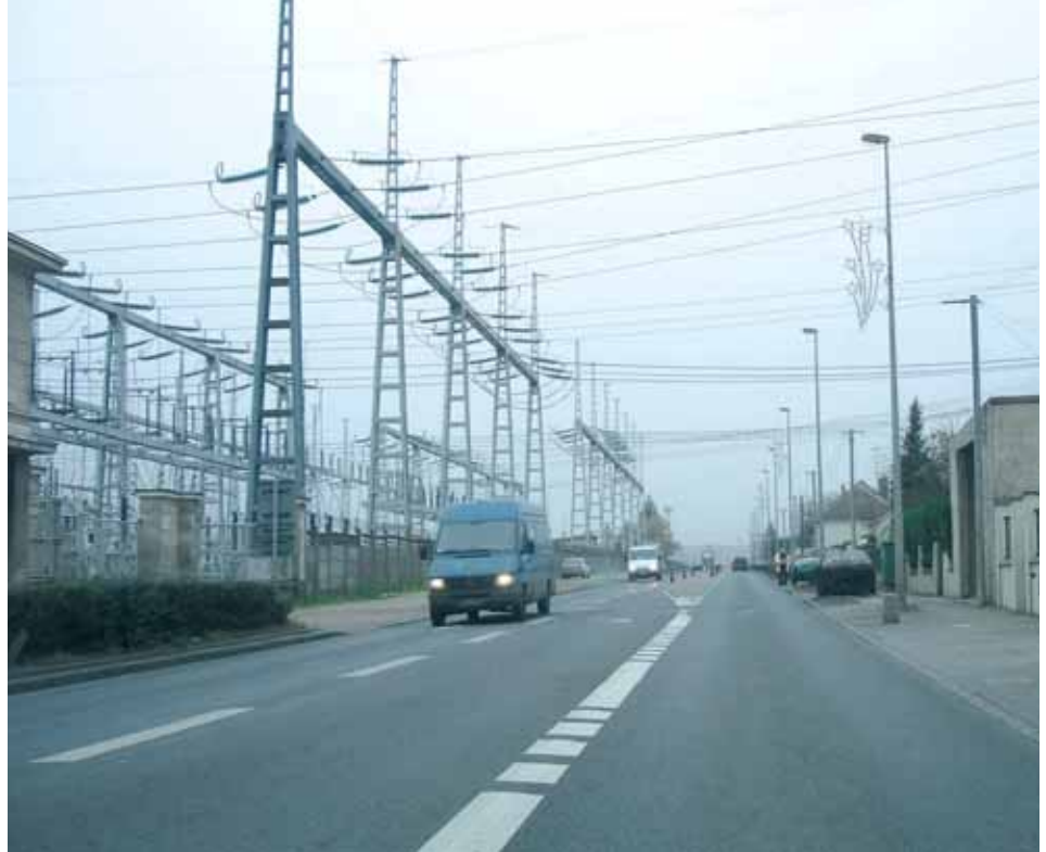
Paysage d'infrastructures de réseaux au sud de Creil : Poste électrique et gare de triage du petit Thérain (Thiverny, Oise Creilloise)
