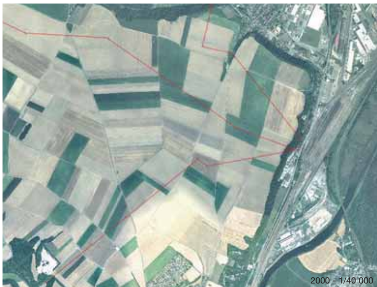
En 2000, pas de changements par rapport à 1985 : les mêmes lignes haute-tension rayonnent à partir du poste de Thiverny.
