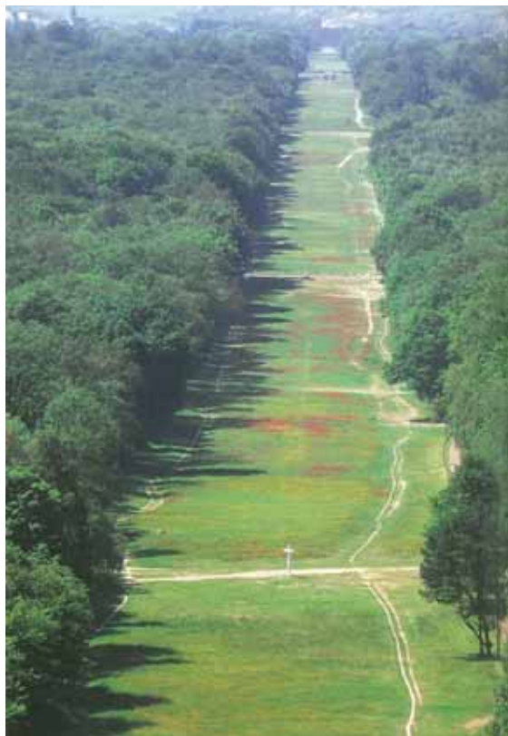
La perspective des Beaux Monts incarne l'articulation du domaine forestier avec le château de Compiègne (Source: Bonneton)
