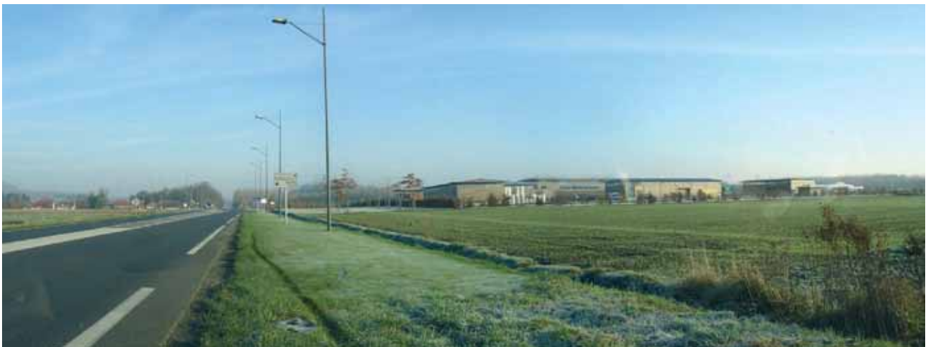
A Passel (Oise Noyonnaise), le parc d'entreprises, installé en secteur agricole, est composé d'architectures en bois. Il a de loin l'apparence d'un bâti agricole. La volumétrie et l'implantation des bâtiments font qu'ils s'étirent dans le fond de vallée agricole sans imposer des volumes saillants (Maître d'Ouvrage : CC* du Pays Noyonnais ; architecte : Aménager le Territoire, Irène Koval).
