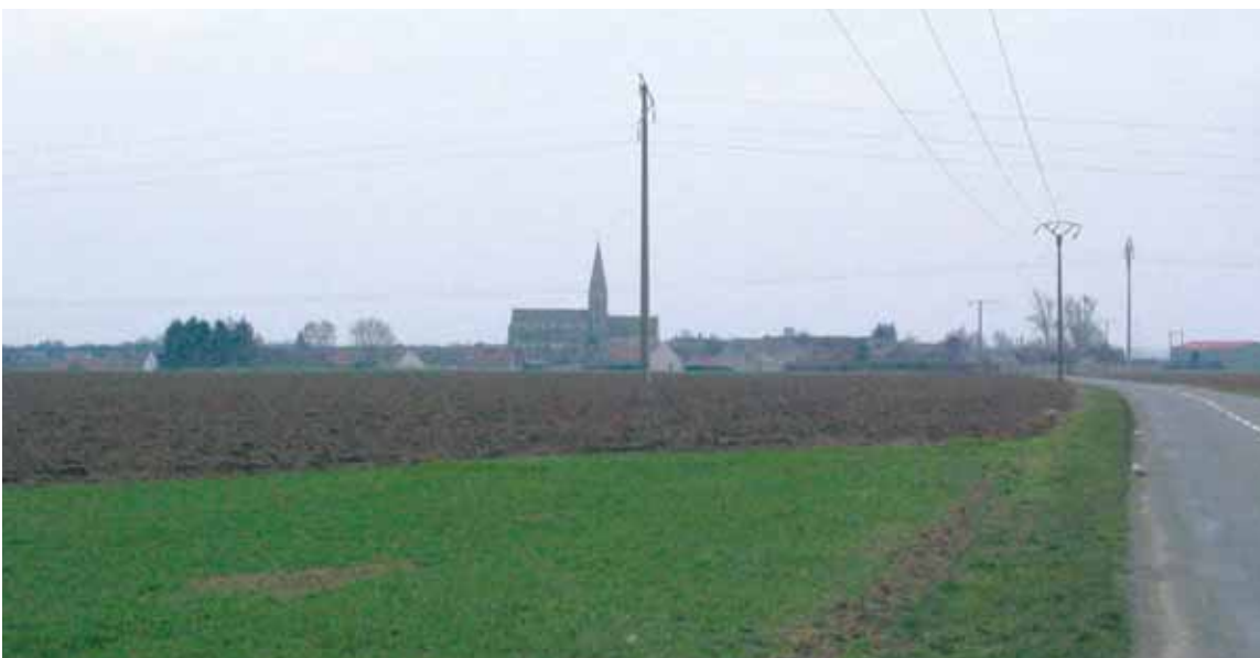
Le village de Cambronne-lès-Clermont dominé par son église. Les nombreuses lignes électriques passant sur le plateau dénaturent le site.
