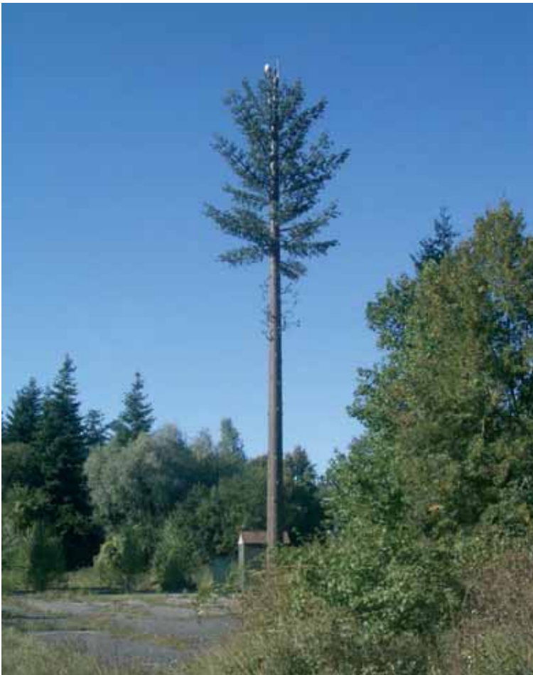
Les faux arbres destinés à camoufler les antennes de téléphonie mobile ne font guère illusions. Ils ne sauraient affranchir de l'enjeu de paysage lié au choix d'implantation des antennes.
