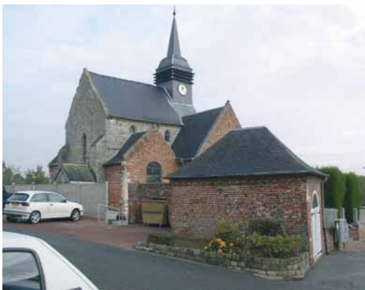
La reprise des édifices effectuée en briques rouges est une trace lisible de la Reconstruction (Fréniches)
