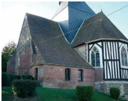
L'église d'Ons-en-Bray combine les matériaux constructifs
