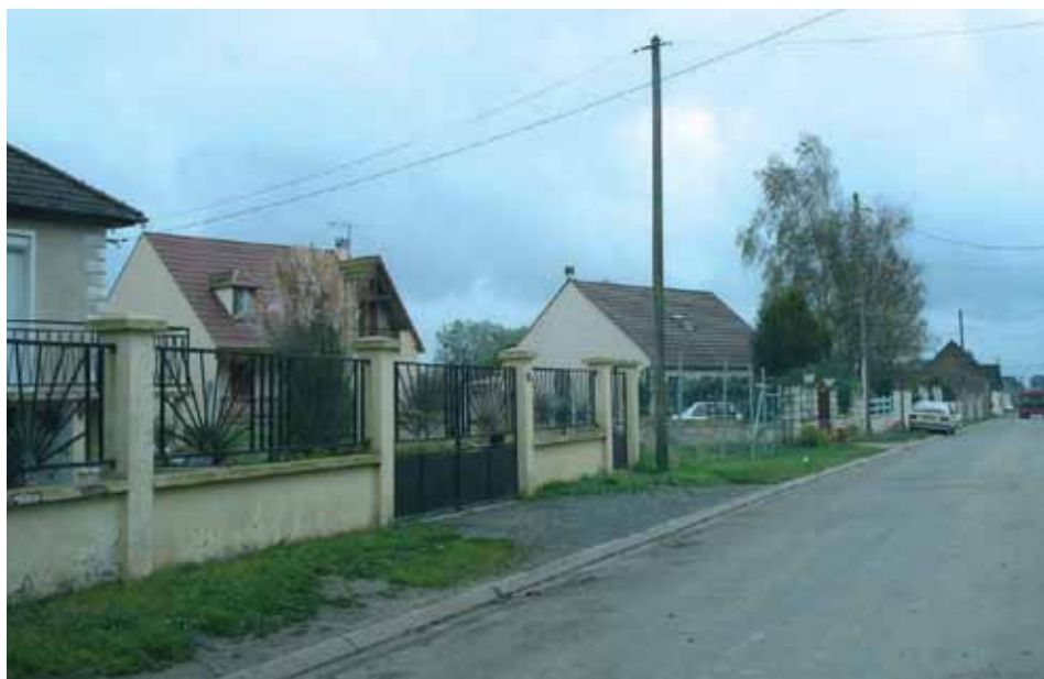
A Ansaulliers (rue principale), non loin de St-Just-en-Chaussée, l'entrée du village a été banalisée par l'implantation d'un ensemble pavillonnaire en rupture avec l'urbanisme rural du Pays de Chaussée.
