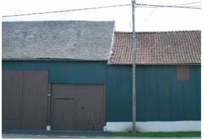
Grange réhabilitée (Auchy-La-Montagne).
