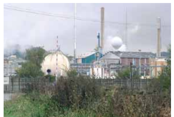
Cheminées, fumées et réseaux électriques participent aux ambiances industrielles manufacturières (Vallée de l'Aisne).
