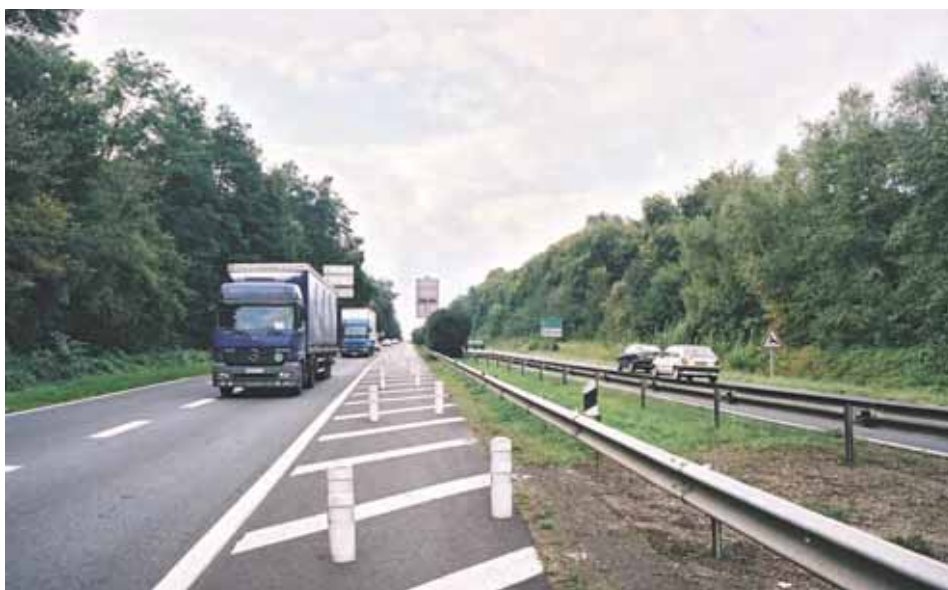
La route nationale RN330 entre Senlis et Creil a été élargie et mise à double voie par section. Le caractère routier est dominant (Aumont-en-Halatte).
