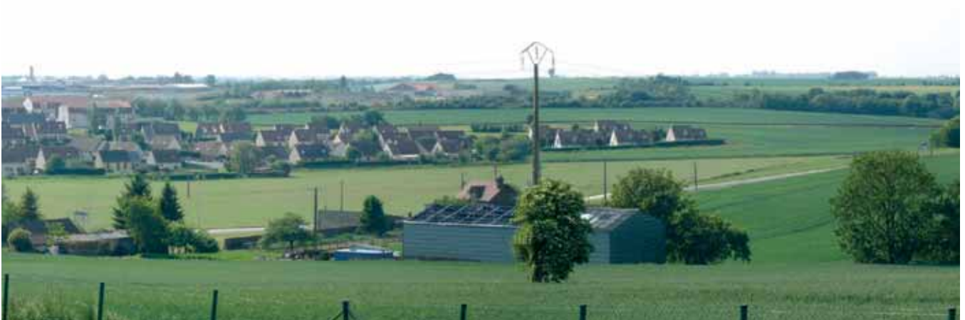
Extension de bourg à Saint-Just-en-Chaussée : avec la remontée du mur tarifaire SNCF (limite de carte Orange), le sud du Pays de Chaussée va subir une forte pression urbaine. Si le développement des bourgs n'est pas adapté à l'urbanisme rural du Pays de Chaussée, il pourrait déstructurer les franges urbaines et remettre en question le caractère rural des paysages.
