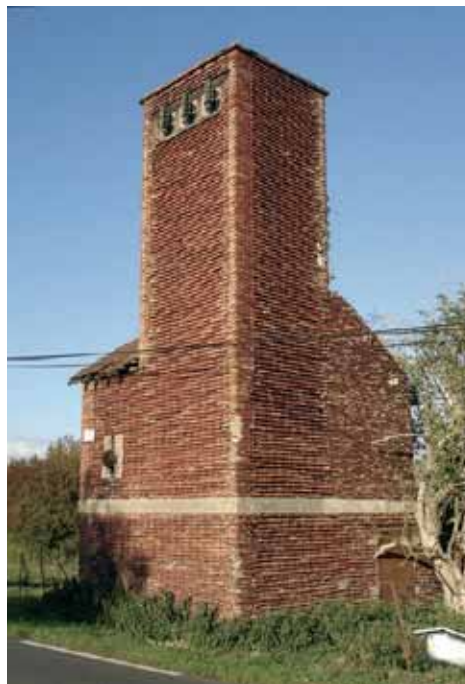
L'argile, très présente dans la toponymie des villages et dans la construction (brique, torchis, tuiles, céramique). Poste électrique en tuiles mécaniques, Villers-St-Barthélémy).
