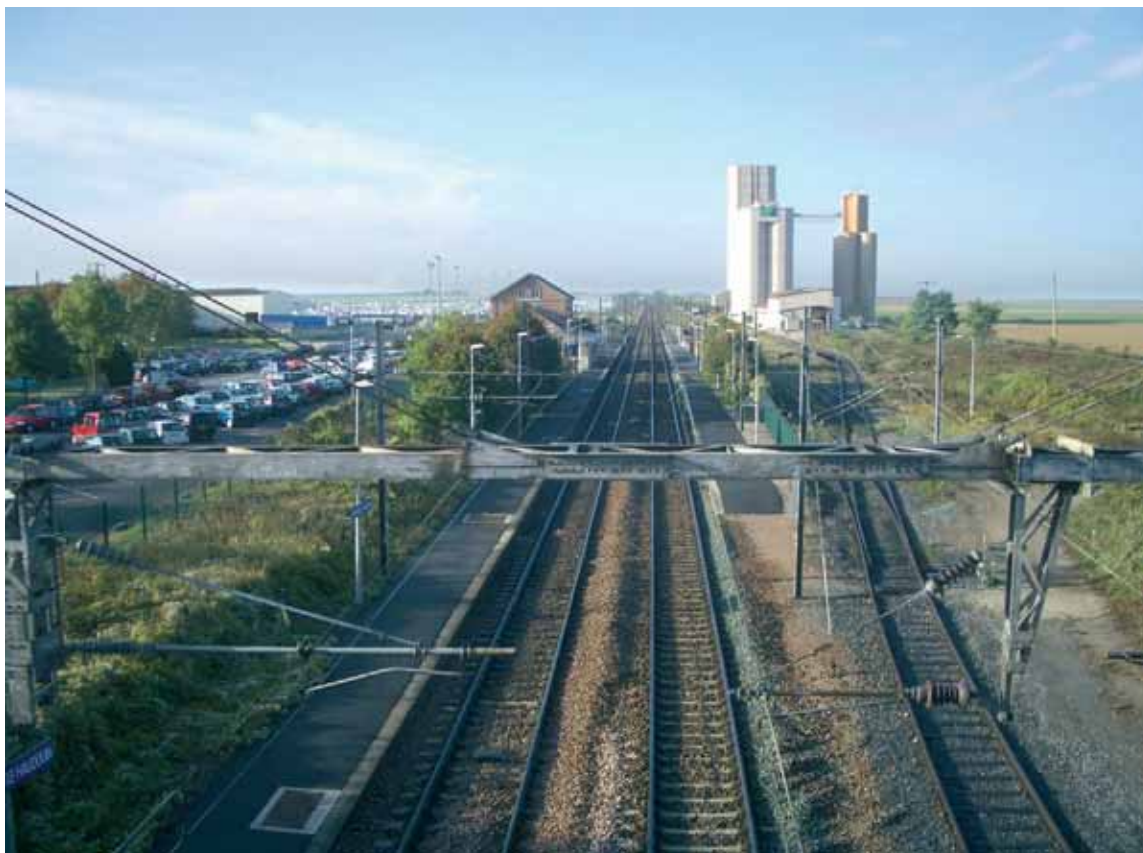
Voie ferrée, gare, bâtiments de stockage et silos agricoles se détachant sur le plateau du Valois à Nanteuil-le-Haudouin. Les terres de ce secteur du sud de l'Oise, situées entre RN et voie ferrée, subissent aujourd'hui une forte pression de développement logistique.
