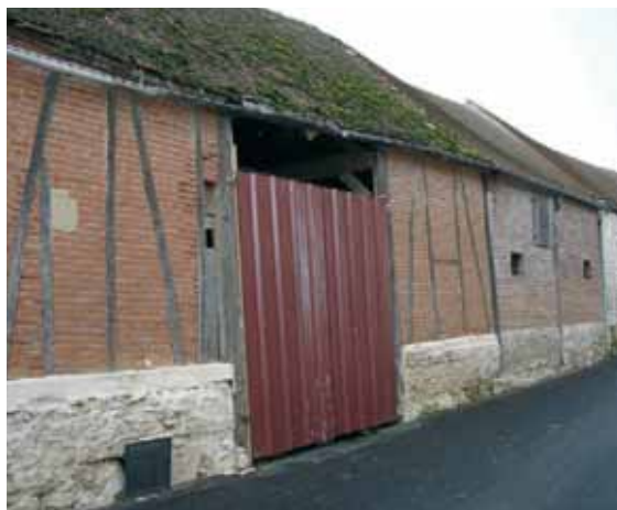
Grange, colombage avec remplissage de brique sur soubassement de pierre (Mambeville).
