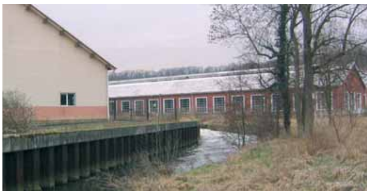
Implantations industrielles par poches dans le fond plat de la vallée humide entre Vaucelle et Béthisy-Saint-Pierre.
