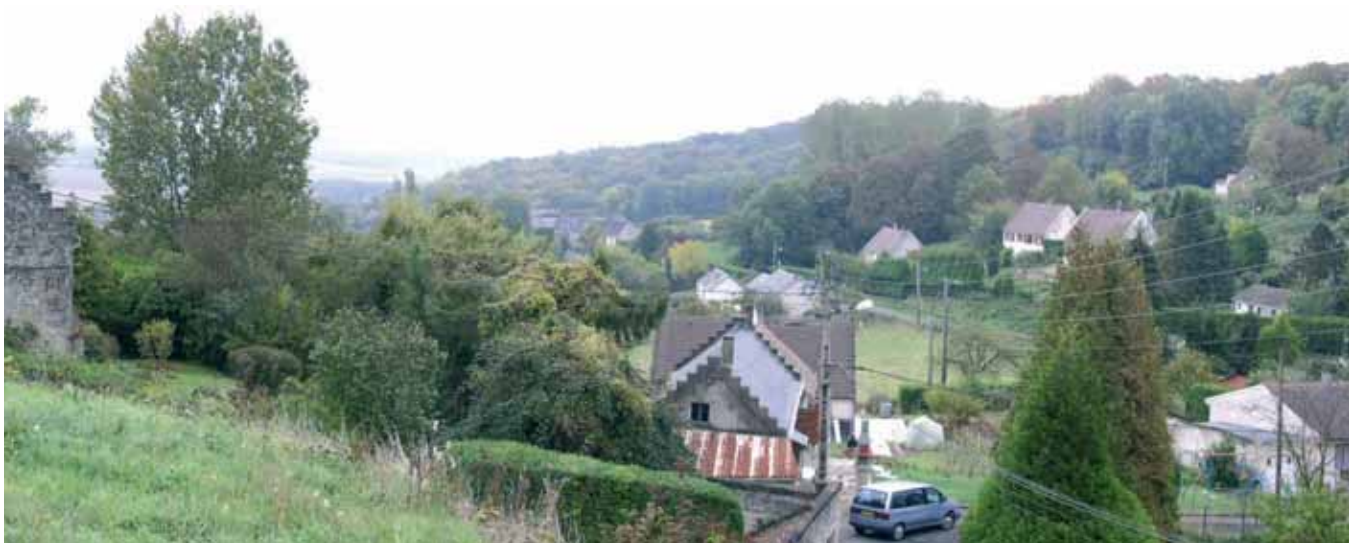
Le village de Jaulzy est installé sur le haut du versant, abrupt et boisé, de la vallée de l'Aisne
