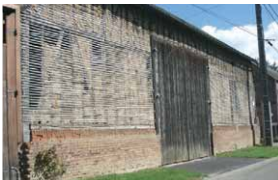
Grange, structure bois et torchis sur soubassement de brique (Lachaussée-du-bois-d'Ecu).
