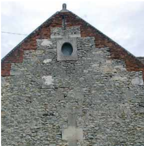
Le couteau picard : élément architectural typique du Clermontois associant brique et pierre
