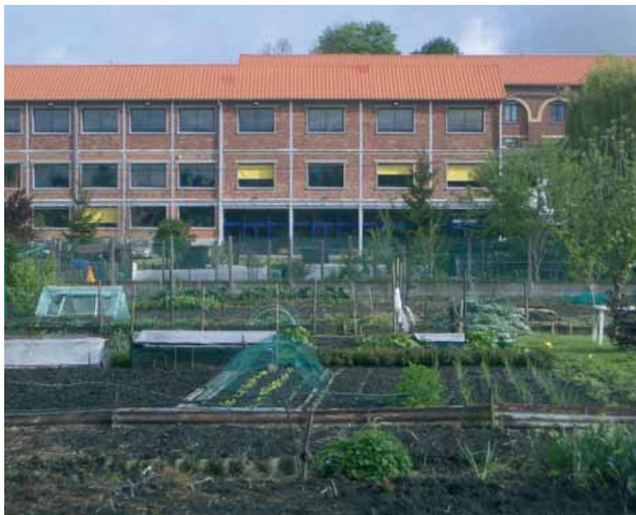
A Chantilly, le long de la Nonette, l'ancienne fabrique de papier photographique «Guilleminot» a fait l'objet d'une réhabilitation et accueille des entreprises.
