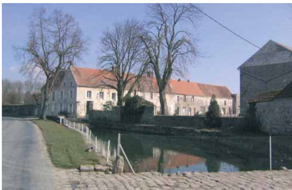
Mare pavée articulant l'espace public du petit village de Reez-Fosse-Martin.
