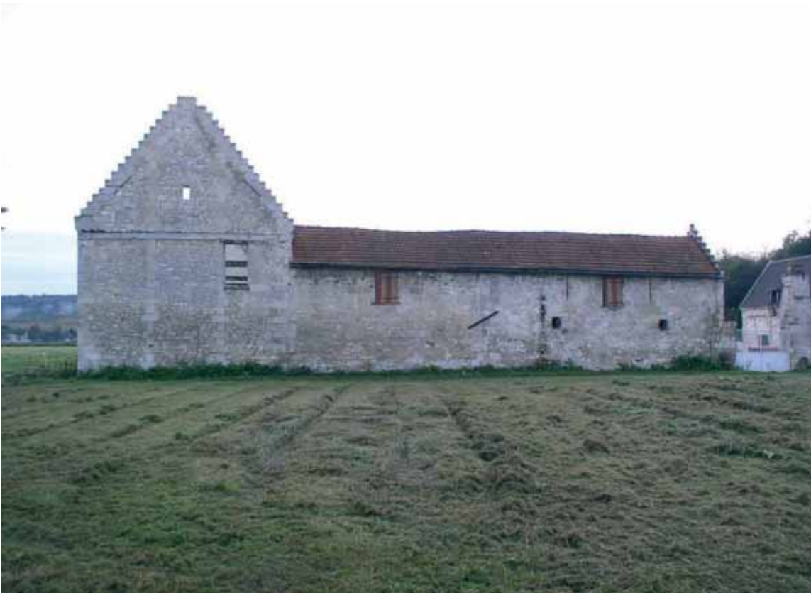
L'entretien du grand bâti agricole qui constitue un patrimoine rural est un enjeu. Cet enjeu est très fort pour les grandes fermes des plateaux mais il est aussi présent plus ponctuellement dans les vallées (Rethondes).
